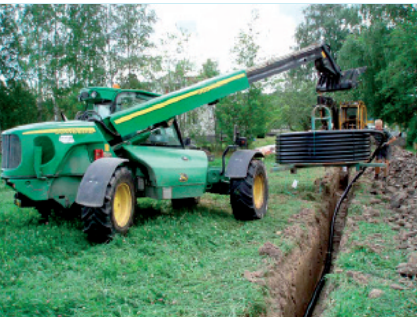
Kulverttrören läggs på plats
