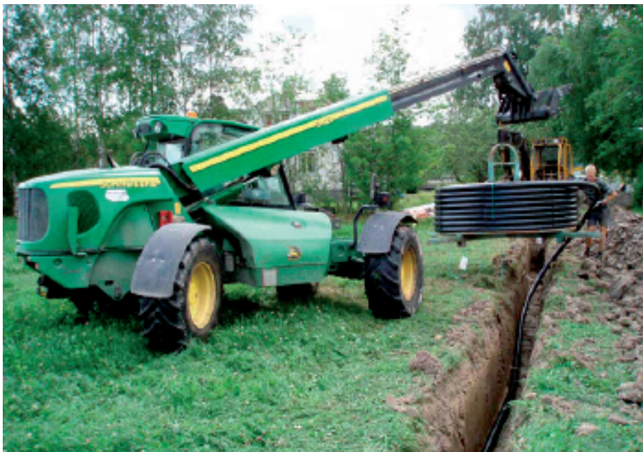
Kulvertören läggs ner.
